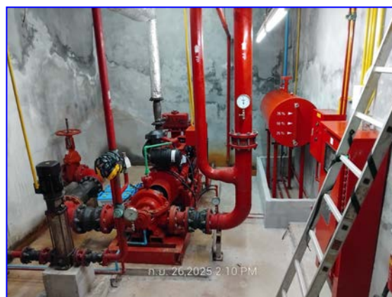
รูปที่ 2.14 ระบบท่อน้ำดับเพลิง และถังเก็บน้ำดับเพลิง
