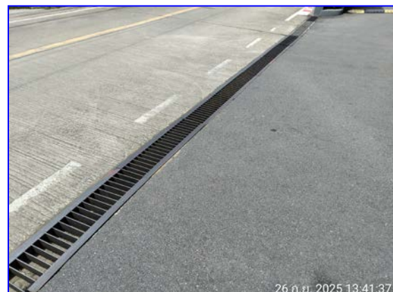
รูปที่ 2.37 รางระบายน้ำ ที่มีตะแกรงดักขยะ
