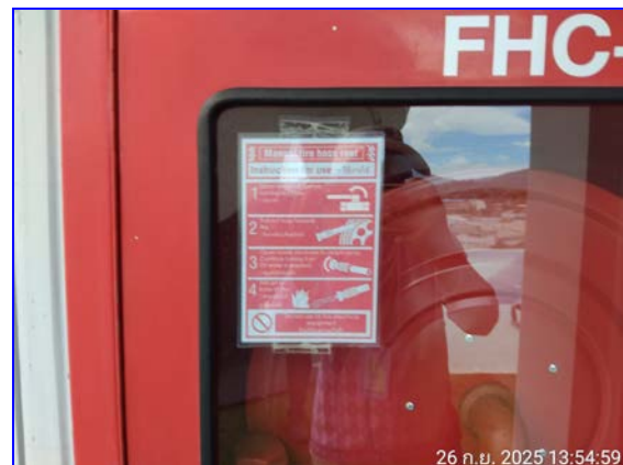
รูปที่ 2.36 ป้ายแสดงวิธีการใช้งานอุปกรณ์ดับเพลิง
