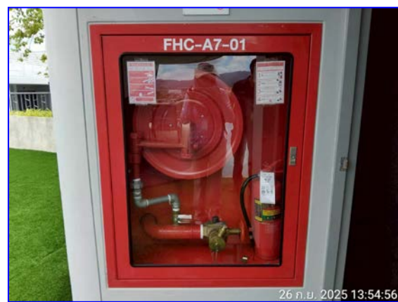
รูปที่ 2.22 ชุดดับเพลิง และถังดับเพลิงชนิดมือถือ
