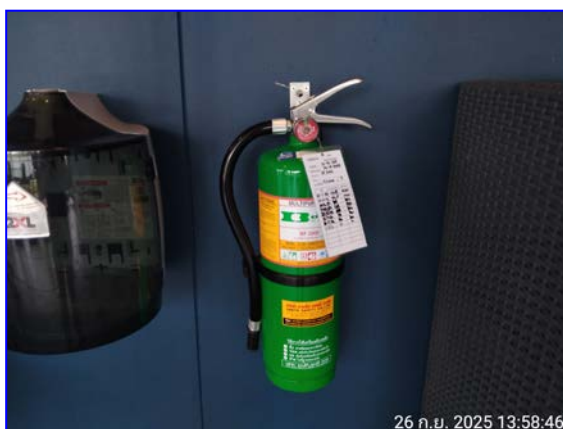
รูปที่ 2.22 ชุดดับเพลิง และถังดับเพลิงชนิดมือถือ
