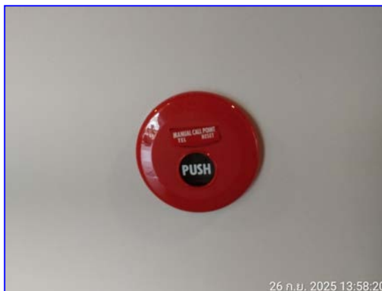
รูปที่ 2.24 อุปกรณ์แจ้งเหตุเพลิงไหม้
