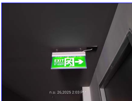
รูปที่ 2.25 ป้ายแสดงเส้นทางหนีไฟ และไฟสำรองฉุกเฉิน
