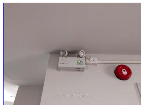
รูปที่ 2.25 ป้ายแสดงเส้นทางหนีไฟ และไฟสำรองฉุกเฉิน
